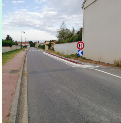
La sécurisation de la route de Craitilleux avec l'implantation d'une chicane.
