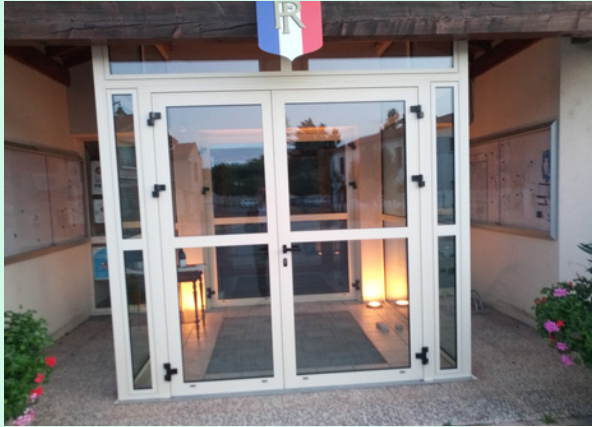
Le remplacement de la véranda de la mairie.
