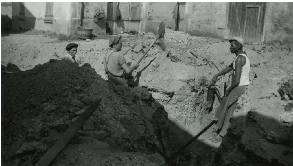
Photo Lézigneux : travaux d'adduction d'eau—Septembre 1960
